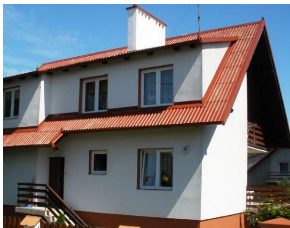
Rys. 5. Przykład zabezpieczenia wykonanego powłoką malarską.
