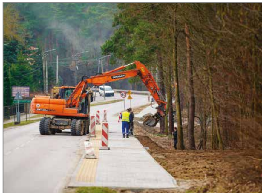
Budowa ścieżki przy ul. Nasielskiej
