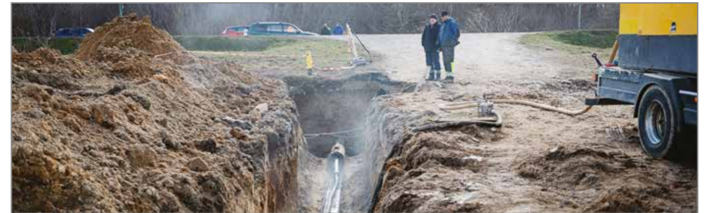
Przewiert sterowany pod drogą krajową wykonała Spółka „WKRA”.
