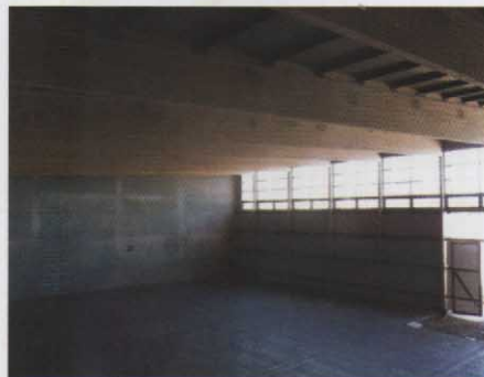
Wylewanie posadzki w hali sportowej
