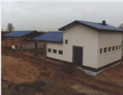
Budynek nowej oczyszczalni
