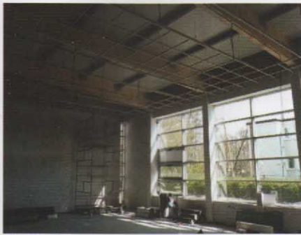
Montaż sufitów w hali sportowej
