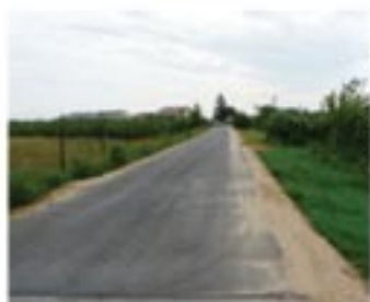
Droga w Wójstwie po remoncie
