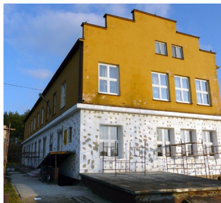
Elewacja w trakcie prac budowlanych
