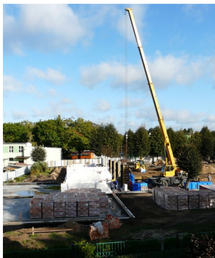
Prace budowlane przy hali sportowej
