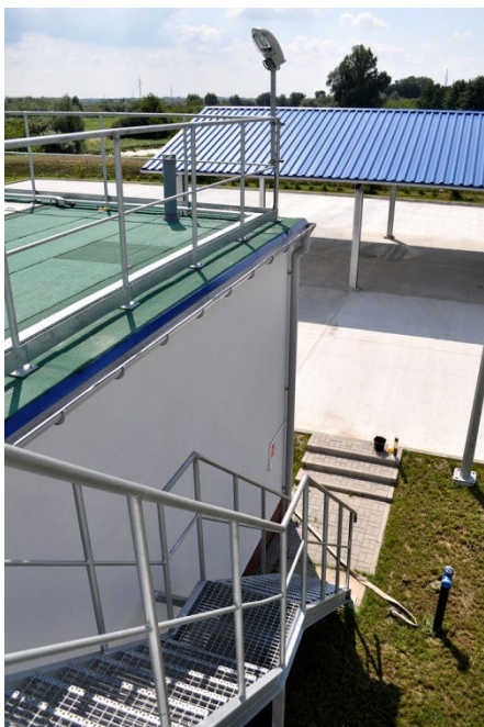
Wejście na dach bioreaktora
