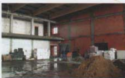
Hala sportowa – prace wewnątrz obiektu
