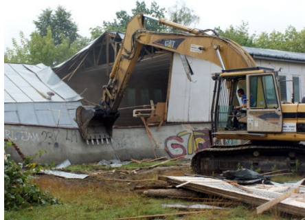
Rozbórka starej sali gimnastycznej
