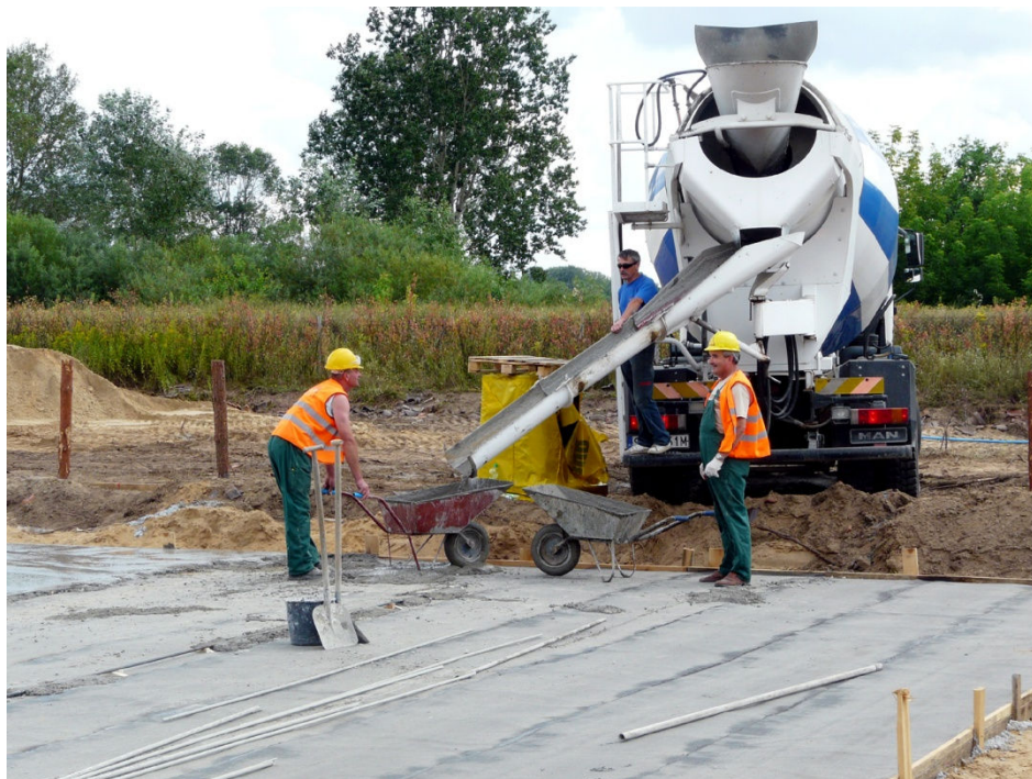
Nowa oczyszczalnia – plac budowy
